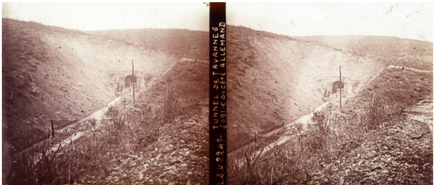
L.S.U. 2247 – Tunnel de Tavannes – Sortie du côté Allemand
